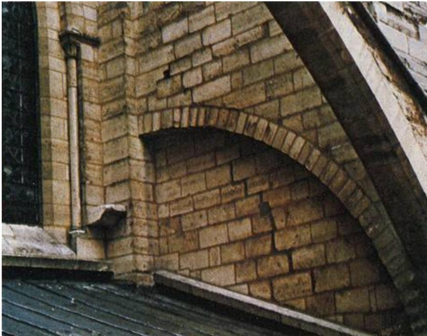
Simile strutturalmente **all'arco a un quarto di cerchio**, l'arco rampante era posto all'esterno e sosteneva il muro ad un livello più alto. In meno di due decenni divenne l'elemento caratteristico degli edifici gotici. Gli archi rampanti originali (di cui rimane una memoria in un arco murato nel contrafforte del transetto meridionale) dovevano aver subito lesioni tali da rendere necessaria nel XIII sec. la nuova configurazione che vediamo oggi.
